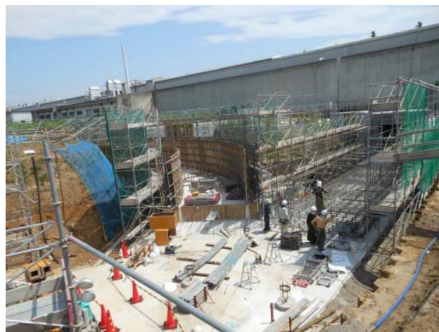
図6：ダンピングリング建設風景
