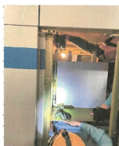
手作業で取外し・設置
