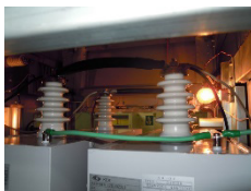
新規コンデンサの接地端子 が上面にあり配線変更
