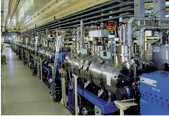
TRISTAN 508MHz Cryomodule
