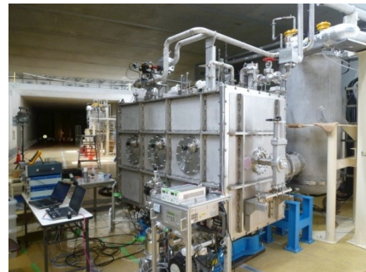
cERL 1.3 GHz Injector Cryomodule
