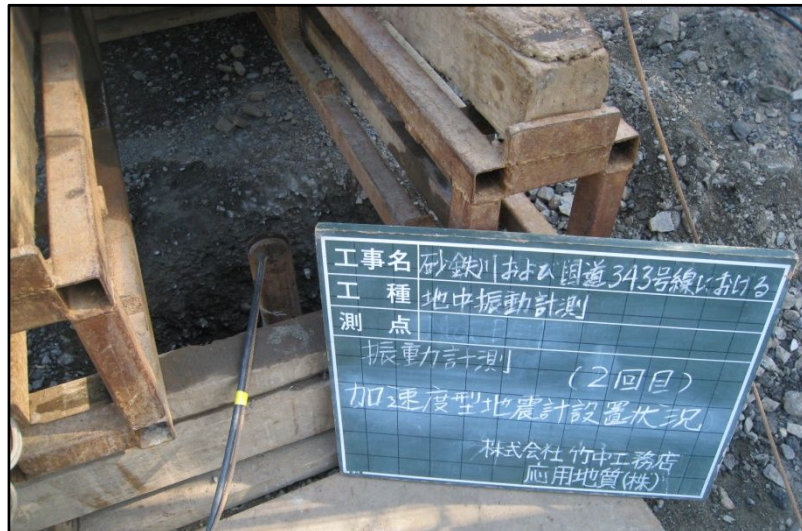
21日：-10m掘削後 地中加速度計設置
