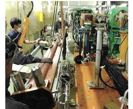
ビームパイプ反転(クリアリング 電極を下側にする)
