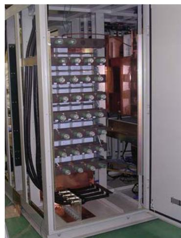
図 6 : キッカー電源 P FN 部 (改造後)
