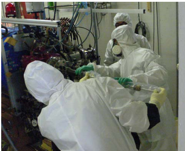
図2：イオン源の点検整備風景
