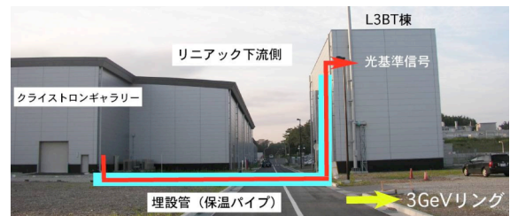
図5：上流から1本の位相安定化光ケーブル(6心)でL3BT棟へと伝送。埋設された断熱パイプに光ケーブルと冷却水パイプを一緒に通している。
