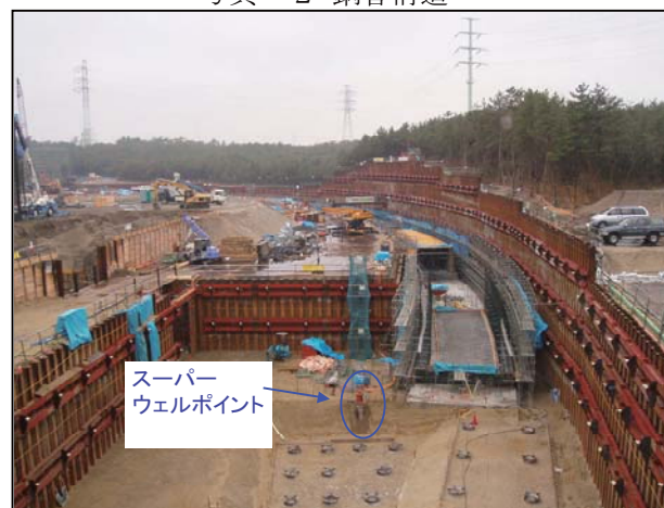
写真-3 ②～③通り床付け完了
