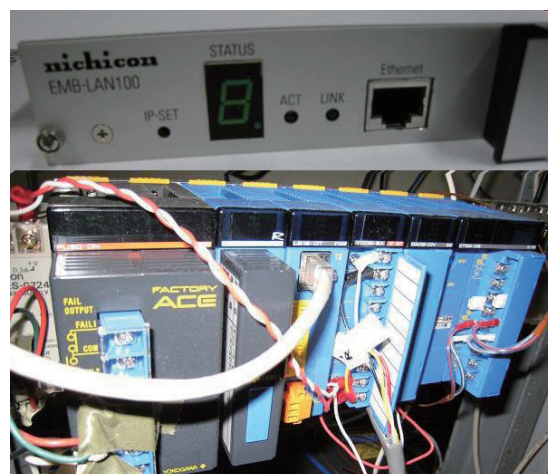
図1 : EMB-LAN(上) & PLC(下)
