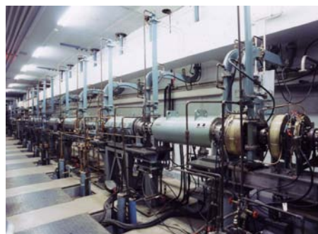
図 1：稼動中の 300MeV 電子線形加速器 (LINAC, 1967 年建設)
