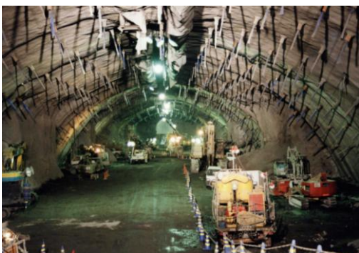
図5：アーチ部掘削(A2, A3)
