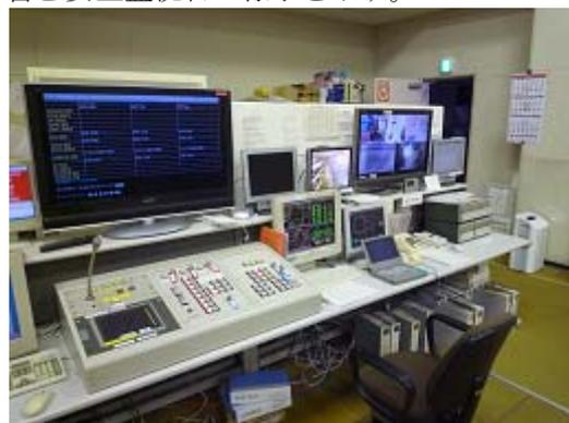
図 1 : PF-AR 及び KEKB、BT の安全システム操作盤(左)と入退域監視端末(右)を含む安全監視台
