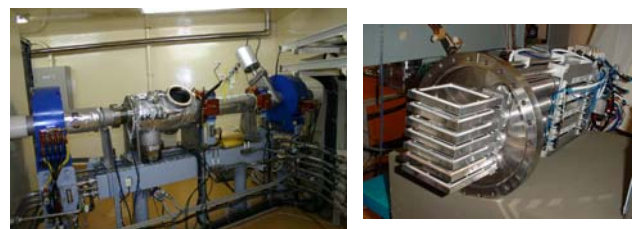
図3：改造前の IS2 と取外した 7 連式 ATT
