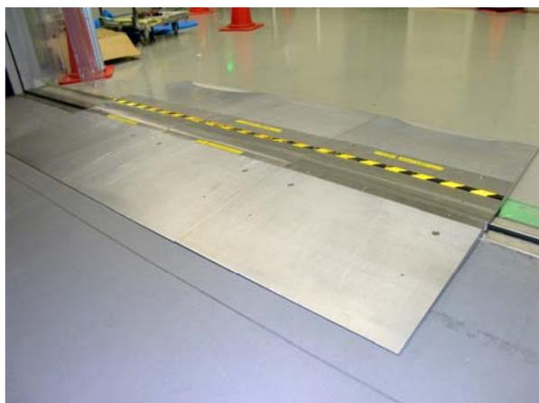
図 5: テストスタンド室からクライストロンギャラリーに通じる扉の段差を超えアルミスロープ。
