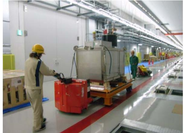
図 4:モジュール電源を、運搬車によりクライストロンギャラリーへ移送。
