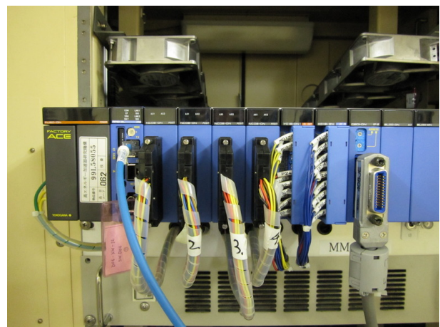
図 4: ビームマスク制御用の F3RP61
