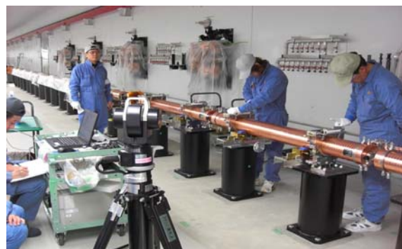
図 7 : アライメント作業の様子
