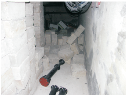
図 7: 倒壊した局所遮蔽用コンクリートブロック
