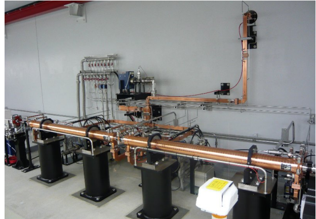
図 23 : SACLA 内据付状況 (右側がビーム上流)
