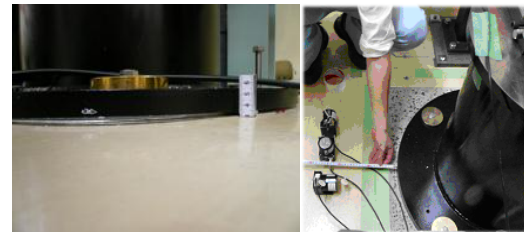
図1. 架台の固定部 左: シム板、右: 研削面
