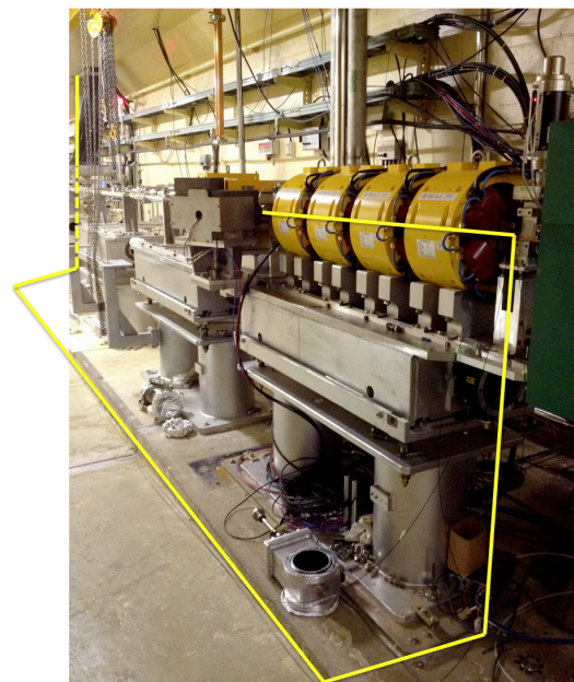
図 10 : 分岐ダクトでのビームロス进行を避ける布設経路の写真
